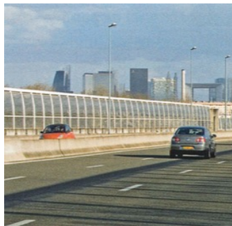
Murs antibruit en polychlorure de vinyle (PVC).
