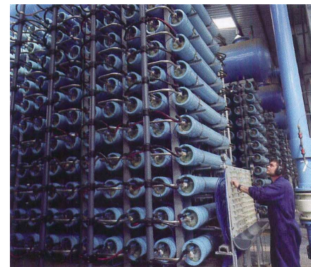
Usine de dessalement.
