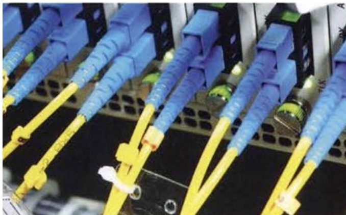
FIG. 12 – Baie de raccordement des fibres optiques. Chaque élément correspond à un abonné.
